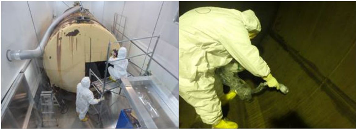
写真 2.3.2-1 低レベル廃液貯槽 No.1 解体作業状況
